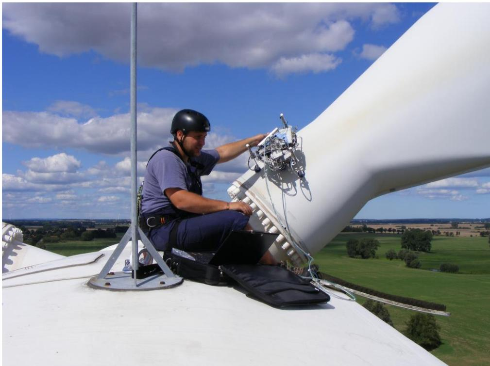
Abb.3.14-3: Roboter wird im Wurzelbereich auf das Rotorblatt aufgesetzt. Der Krümmungsradius im Wurzelbereich beträgt 0,8 m, dies dürfte bezogen auf den Radius die Grenze dessen sein, was der Roboter bewältigen kann.
